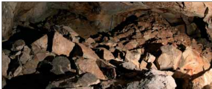
Obr. 5: Komora K4 – místo se sníženou stabilitou, výraznými opady stropu a zvaly
